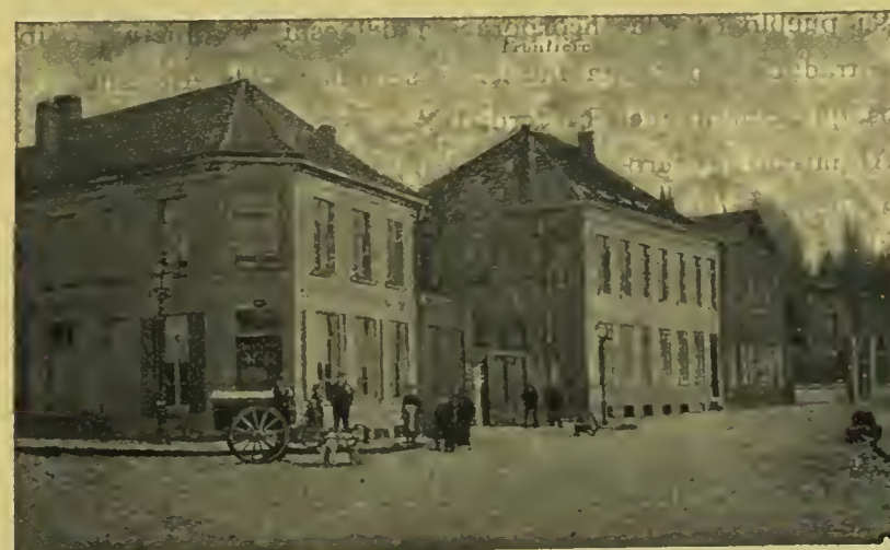
UNA CASA EN LA FRONTERA EN HALLUIN (NORTE)
